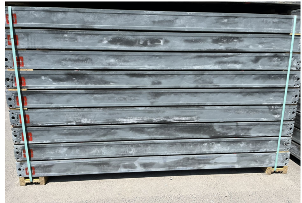
Abbildung 1: Zwischenlagehölzer beim Stapeln von Schalelementen
