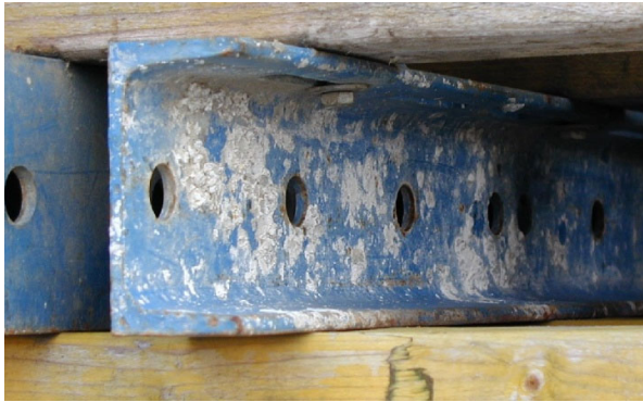
Abbildung 8: Zulässige Verschmutzung an der Stahlgurtung
